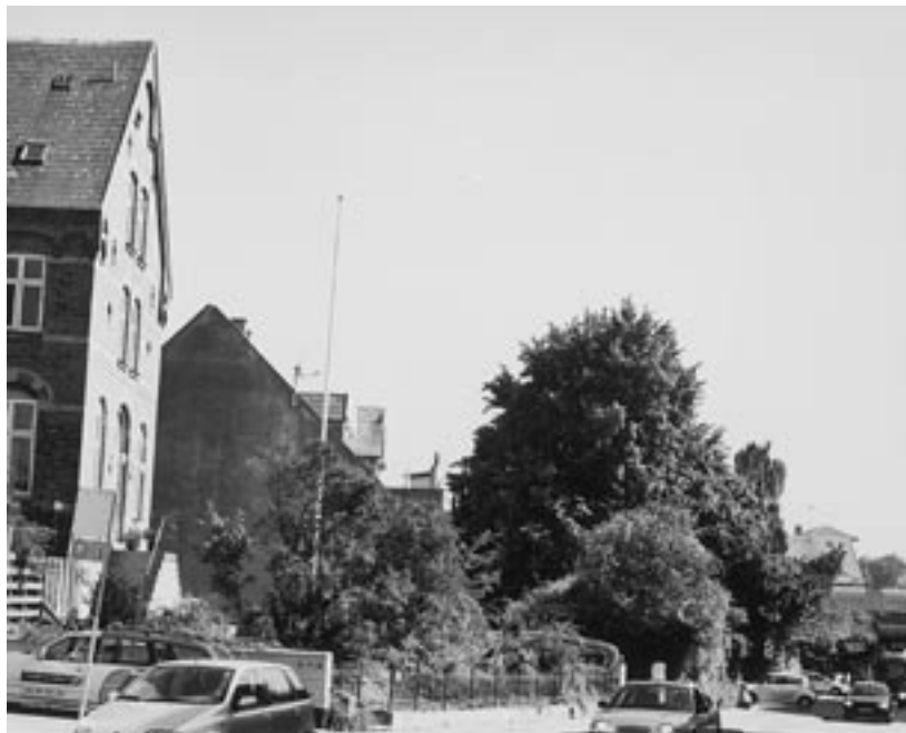
Selv på et nyt foto, kan man se, hvor tæt på Ove Hohlenbergs Minde, jernbanen løber. Det var en farlig sag at krydse sporene, da de løb tværs over Hellerupvej.
